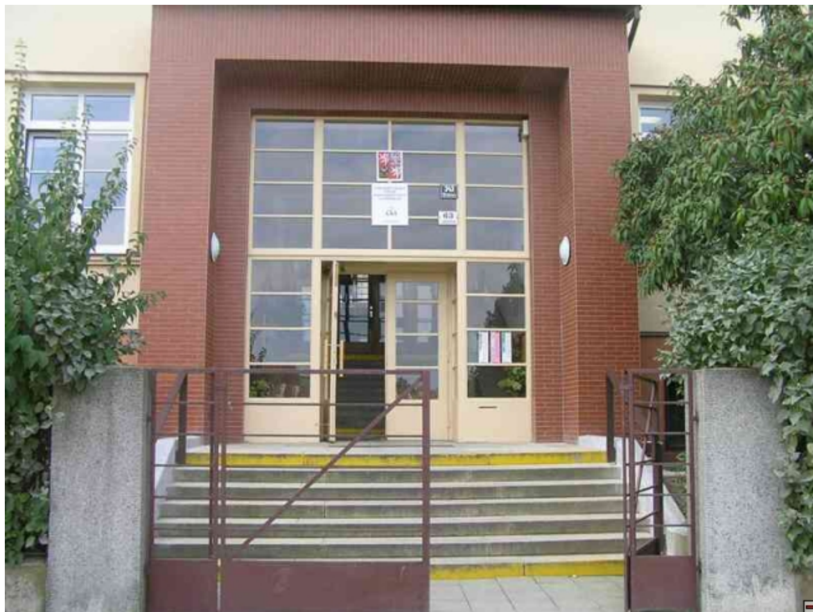
Vstup do budovy školy
